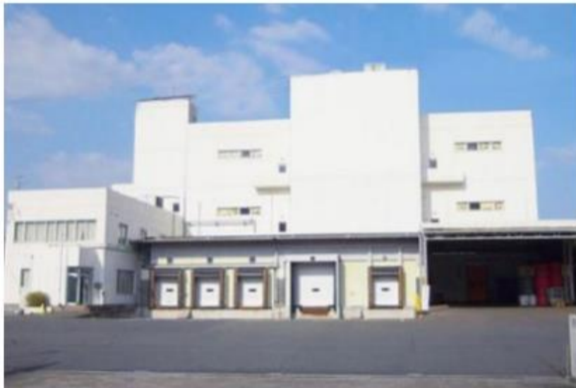
唐津物流センター 外観
