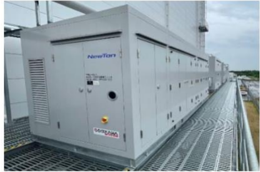
名古屋物流センター ノンフロン冷凍機
