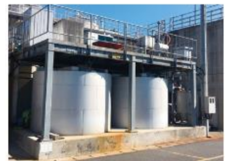
下関工場のバイオガス発電設備
