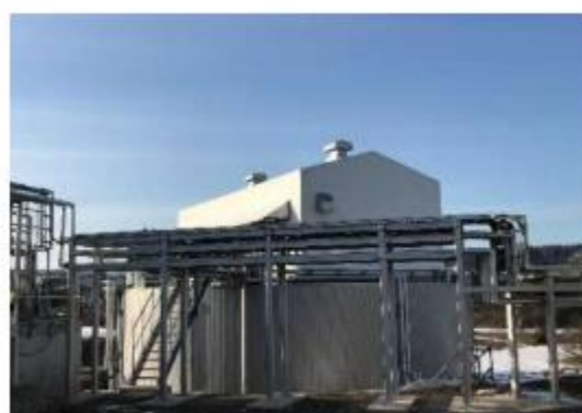
食品残渣等を発酵させる発酵槽
