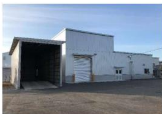
バイオガス発電機が設置されている機械棟
