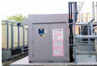
第一工場 F 級冷蔵庫 ノンフロン冷凍機
