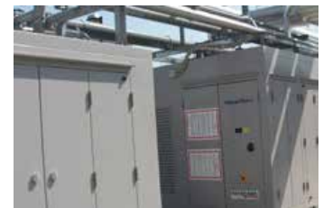
乾麺ライン ノンフロン冷凍機
