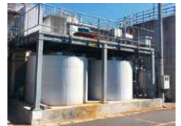
下関工場のバイオガス発電設備
