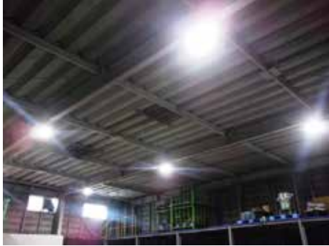
LED照明設備
