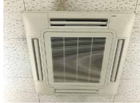
高効率空調設備
