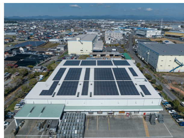
(株)マリンアクセスに設置した太陽光発電パネル(2023年1月設置、年間約65万kWh、約260トンのCO 2 排出量の削減見込み)
