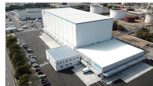
名古屋物流センターの外観
