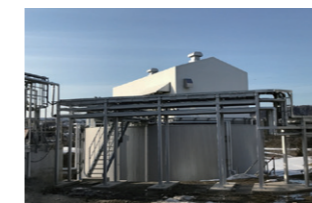
食品残渣などを発酵させる発酵槽
