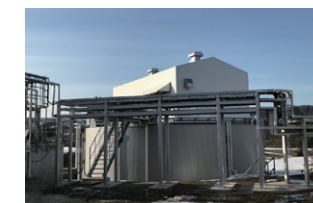
食品残渣などを発酵させる発酵槽
