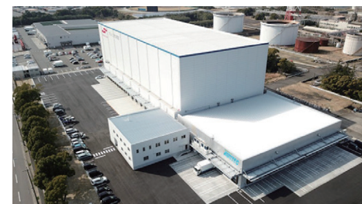
名古屋物流センターの外観
