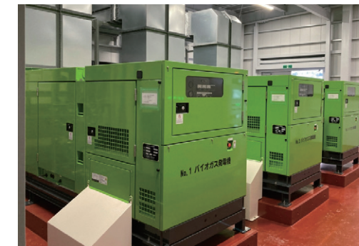
メタンガスから電力を発生させる発電機
