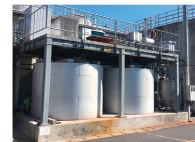
下関工場のバイオガス発電設備
