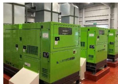
バイオガス発電機が設置されている機械
