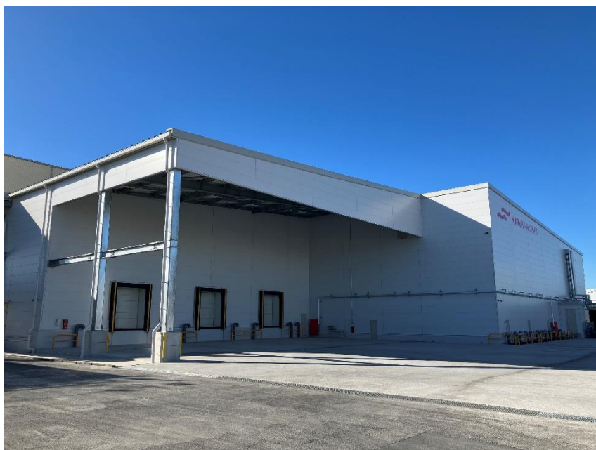
冷凍倉庫外観
