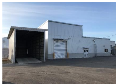
発電機などが設置されている機械棟
