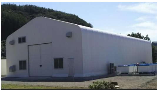
山形県遊佐町にある陸上養殖設備
