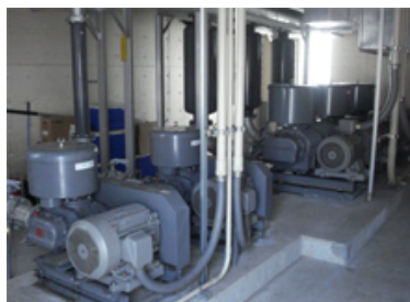
排水プロアー（55kwH/台）
