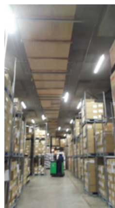
LED照明設置倉庫の庫内
