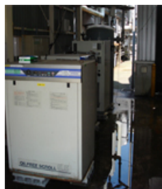
コンプレッサー（40kwH）
