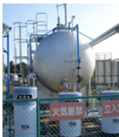
ガス液化器（40kwH）
