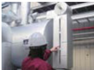
冷凍機器CO 2 レシーバーでの冷媒量の日常点検風景
