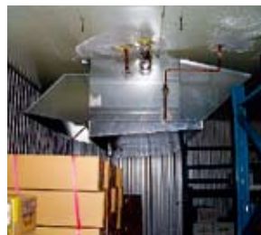
▲高効率ユニットクーラー(上:吸い込み、下:吹き出し)を採用したことにより、大幅な省エネが図れた
