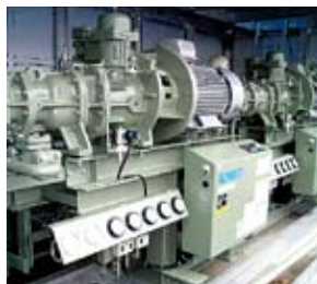
▲冷凍機など主要機器へのインバータ設置によりきめ細かな運転管理が可能になった
