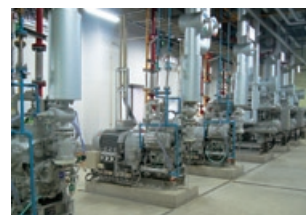
アンモニア冷媒を使用した冷凍機器
