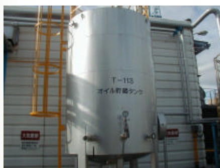
オイル貯蔵タンク
