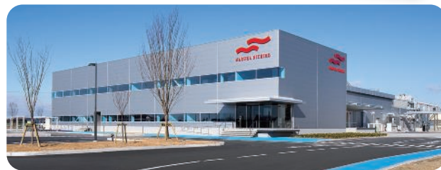
2017年4月より稼働した冷凍食品新工場「新石巻工場」
